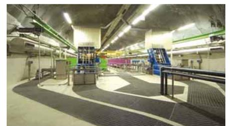
Jährlich werden bei den fünf Pustertaler Kläranlagen 200 Tonnen Rechengut dem Abwasser in der mechanischen Reinigungsstufe entnommen.
